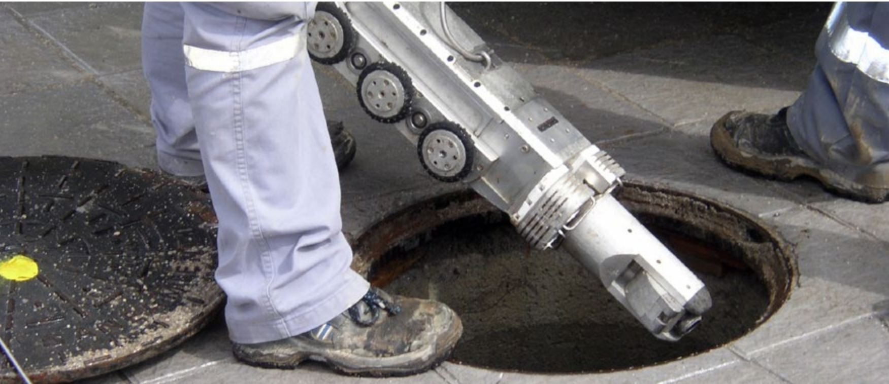
Cámara de inspección da rede de sumidoiros
