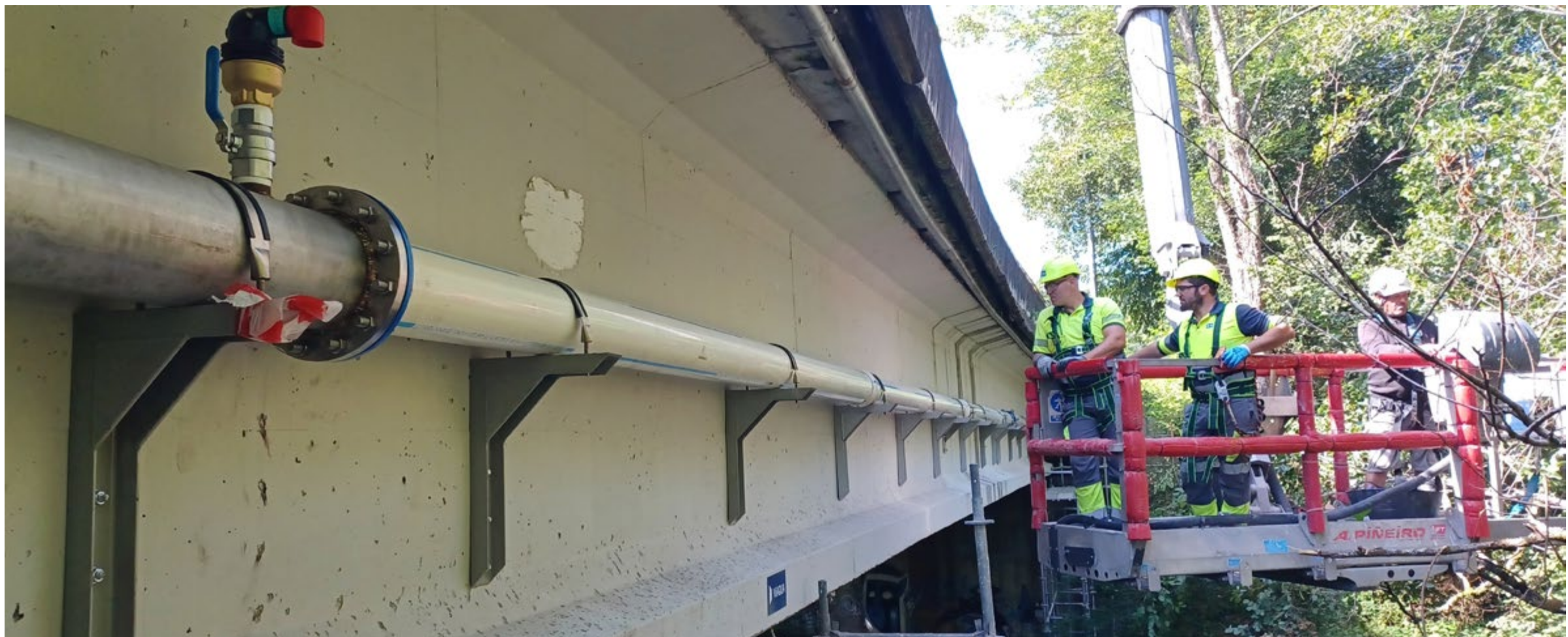
Ampliación da rede de abastecemento na parroquia de Bora, concello de Pontevedra
